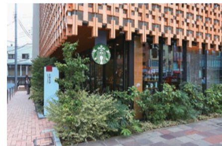
木材格子がトレードマークの15号館
