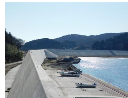
↑新たに建設された防潮堤は12メートルの高さです。
