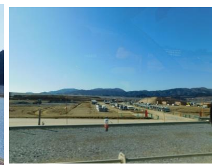
↑沿岸部の大規模なかさ上げ工事の様子
